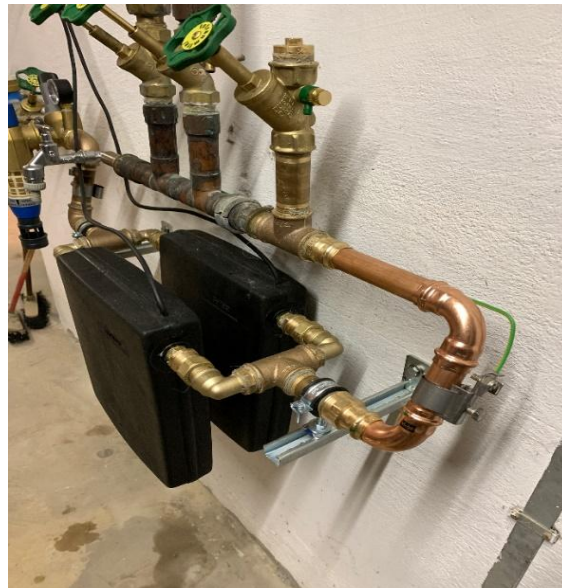
Einbauschema für die korrekte Parallelschaltung der Induktionsrohre
